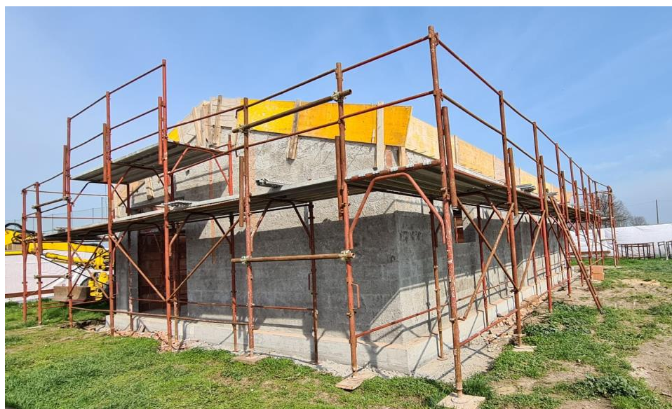
Cacciola – Capanno in ristrutturazione
